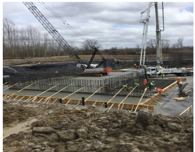
Concrete Pour 1.6 MGD SBR WWTP Trenton, Tennessee
